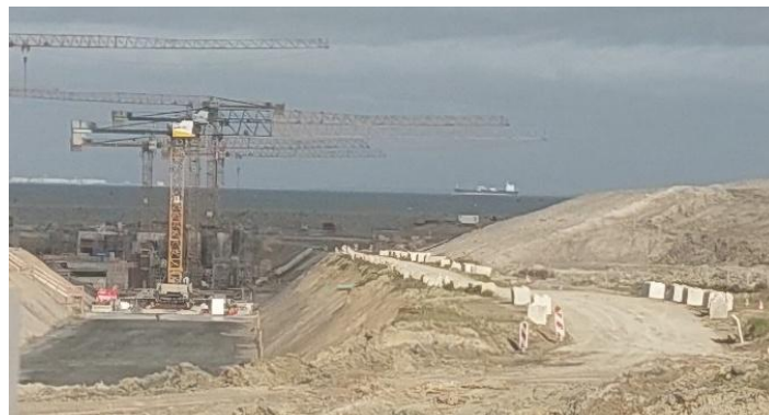
Hinter den Kränen der Tunneleingang auf deutscher Seite. Am Horizont die Baustelle auf dänischer Seite
